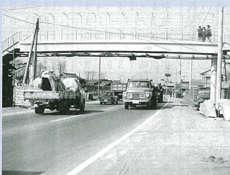
完成直後の中3丁目歩道橋
