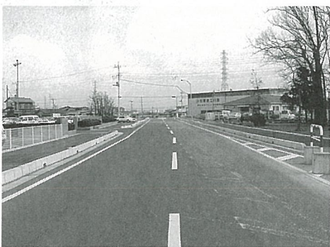
道路の整備を進めます
