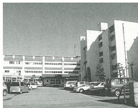
耐震工事を行う幸手小学校
