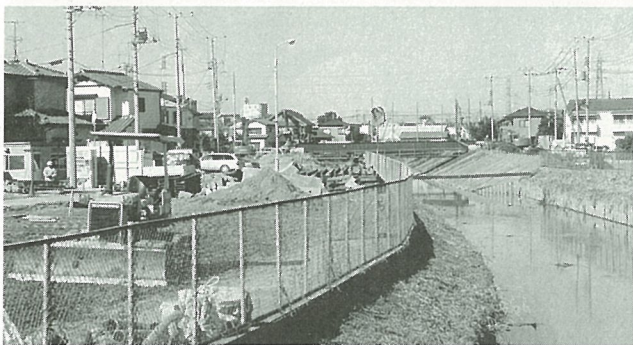
倉松川の改修工事も進んでいます
