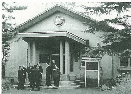
現幸手小学校内にあった 図書館(公民館)
