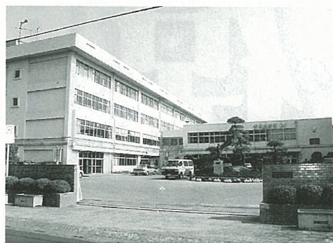
幸手中学校の耐震補強工事を行います
